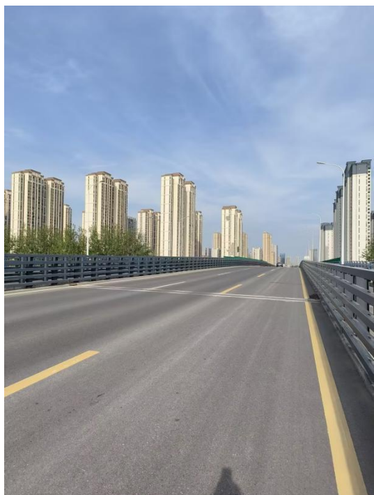
上跨京台高速公路分离立交桥
