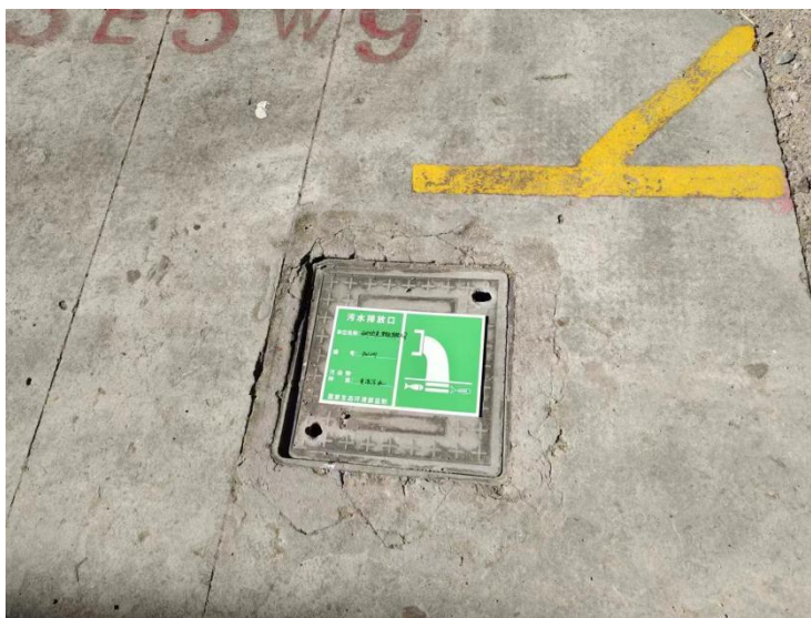
废水排放口标志
