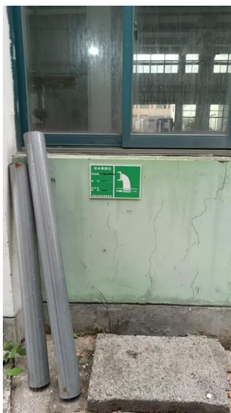
DA001 生活污水排放口
