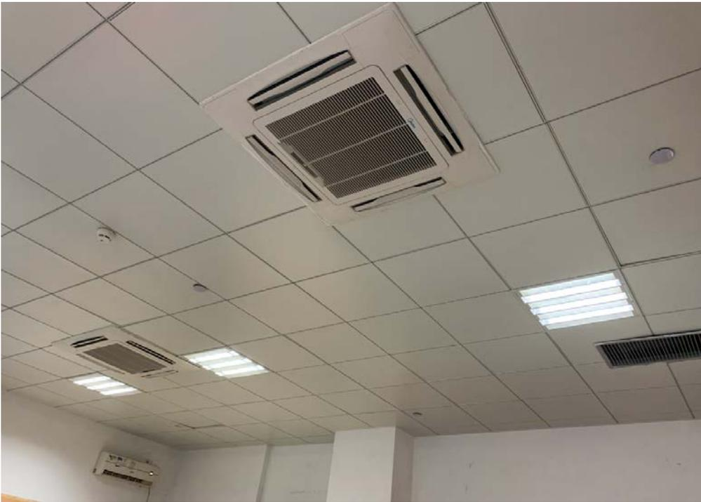
图 4-6 通风换气装置实物图
