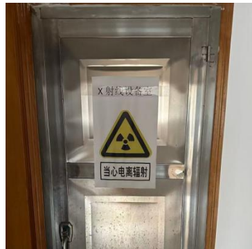
图 2 设备贮存间的电离辐射警告标志
