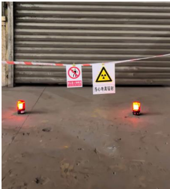
图 9 控制区边界电离辐射警告标志、警告牌、警戒线、工作状态警示灯
